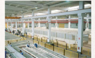
Çeşitli Sanayi Yapıları İzmir
