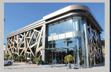
Çeşitli Sanayi Yapıları İzmir
